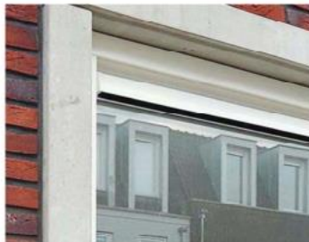
Licht grijze beton lufel
