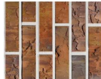
Verticaal metselwerk - lichte voeg
