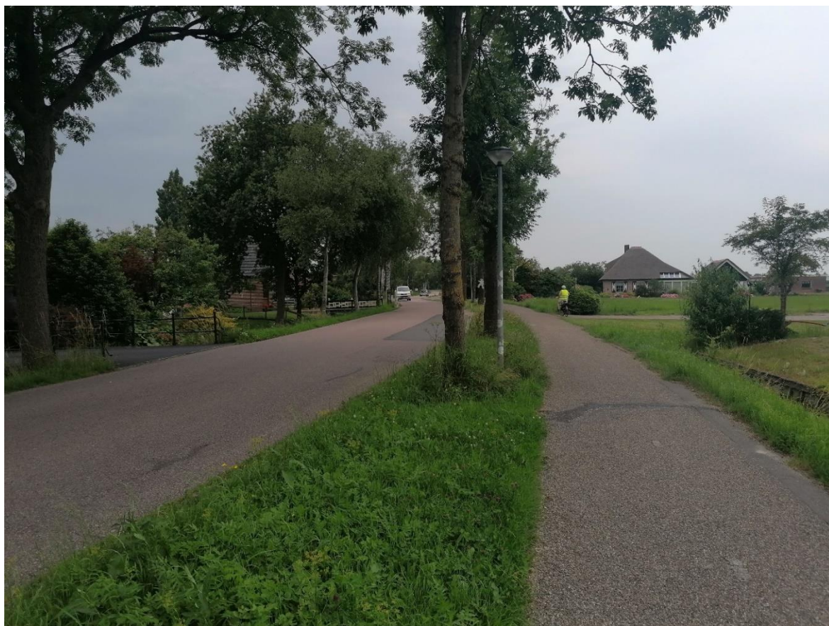
5 ZUIDERDRACHT TUSSEN GILDENWEG EN N-506 (kijkrichting naar noorden)
