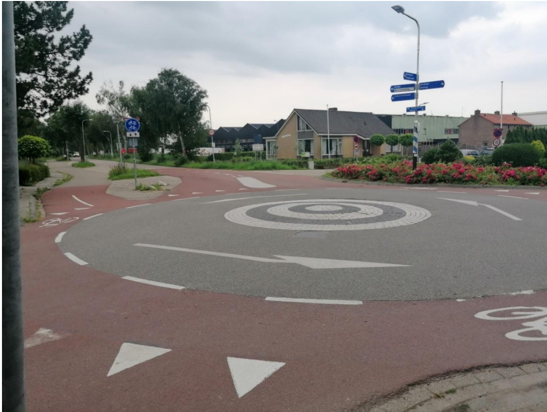
1 TOEGANG ZUIDERDRACHT VANAF MINIROTONDE (kijkrichting naar zuiden)
